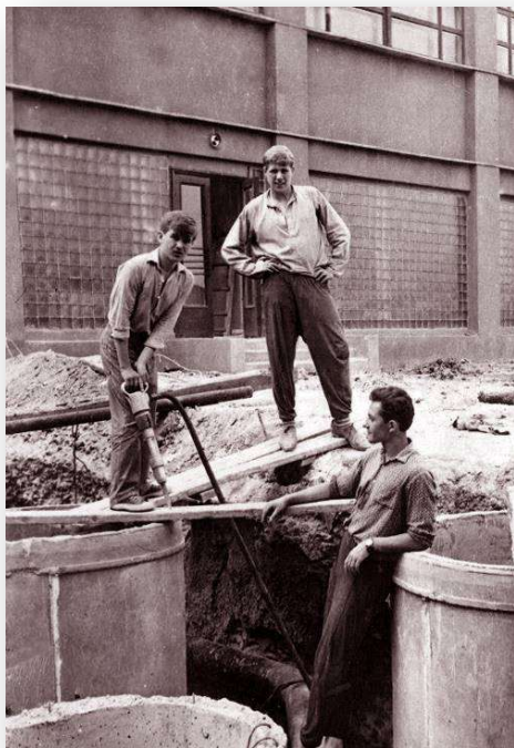
Бойцы ССО «Моторист-68» на строительстве бассейна, 1968 г.
