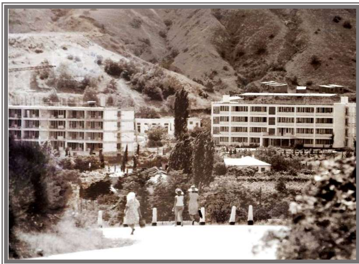
Строительство спального корпуса № 2, 1974 г.
