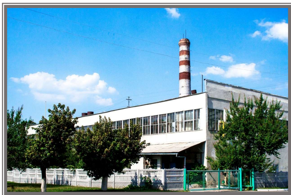
Котельная на газе теплопроизводительностью 8 МВт, 1969 г.
