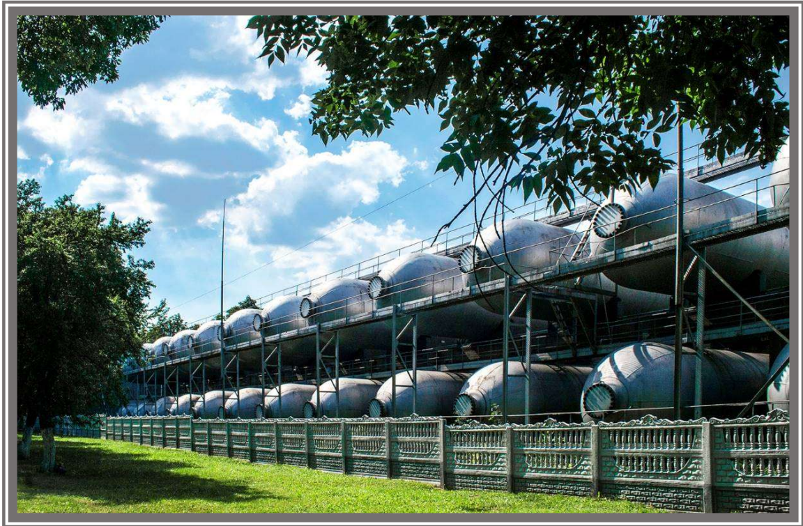
Газгольдерная станция, построена в 1972 г.
