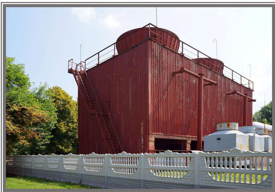
Градирня, построена в 1968 г.
