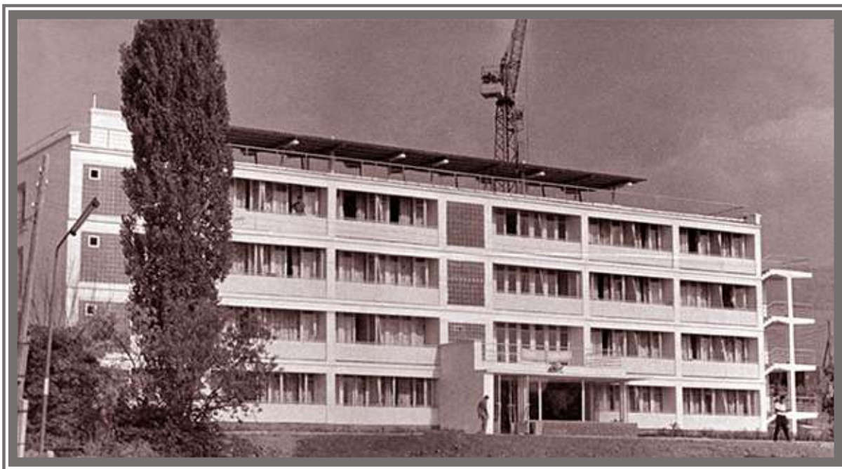
Строительство спального корпуса № 1 в пос. Рыбачье, 1967 г.
